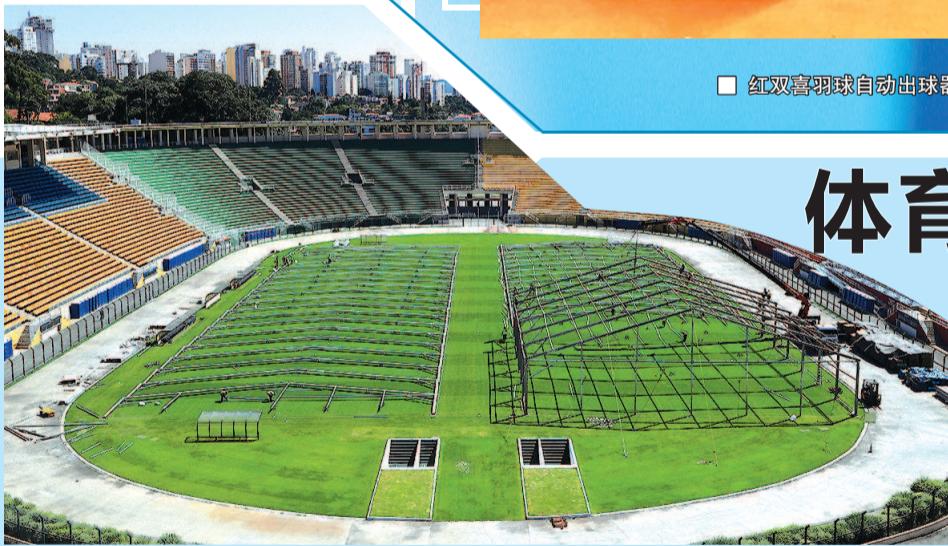
■ 帕卡恩布体育场正在建造方舱医院
