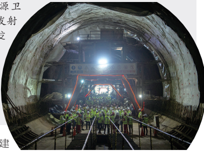
► 印尼雅万高铁瓦利尼隧道内景 新华社 发
