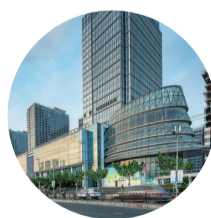
高尚领域 大型城市综合体即将建成
