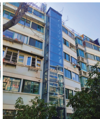
▲馨康苑8号楼电梯外观
