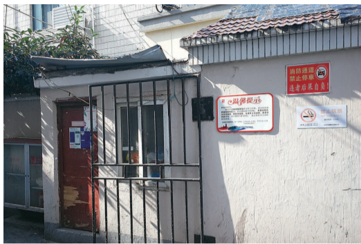
谭家桥小区的门卫室大门紧闭,屋内空无一人
