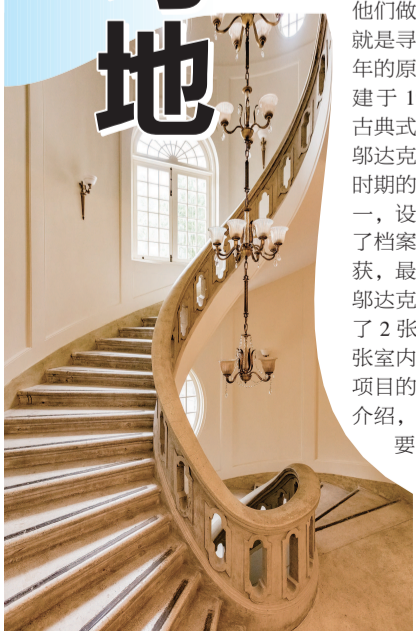
1号楼内修旧如旧的弧形楼梯
