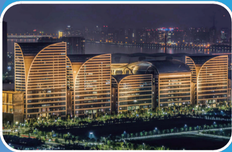
● 杭州国际博览中心
