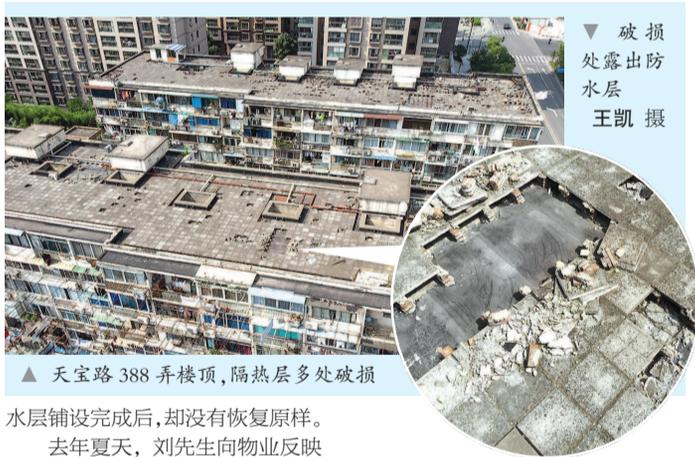
▲ 天宝路388弄楼顶,隔热层多处破损
