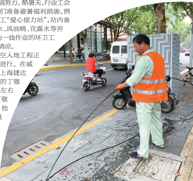
► 丁敬飞在整理线缆 见习记者 陆佳慧 摄
