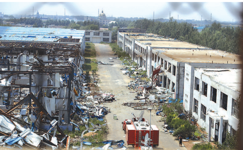
■ 图为龙卷风过后,开原西部的工业园区内数栋厂房被摧毁,成为废墟
