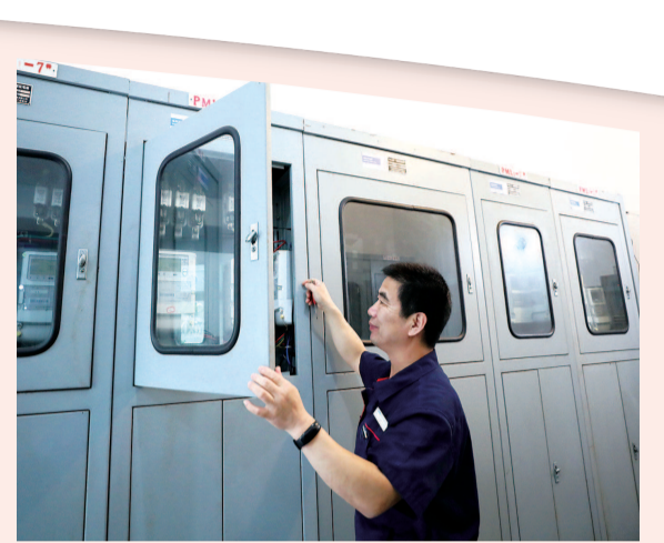
物业人员定期检查设备设施
