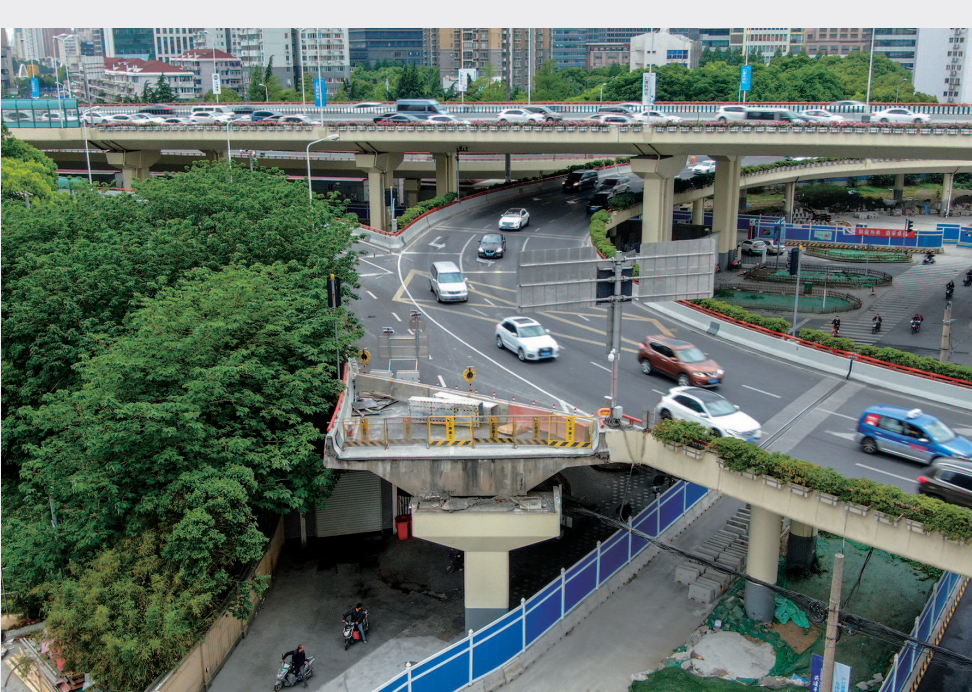
■天目路“大转盘”两根下匝道顺利拆除
