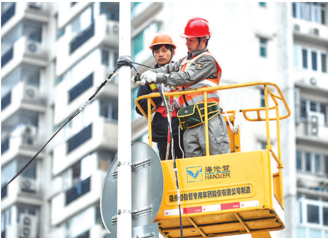
■ 位于天虹路与天宝路路口的违规架空线被拆除 本报记者 陈梦泽 摄
