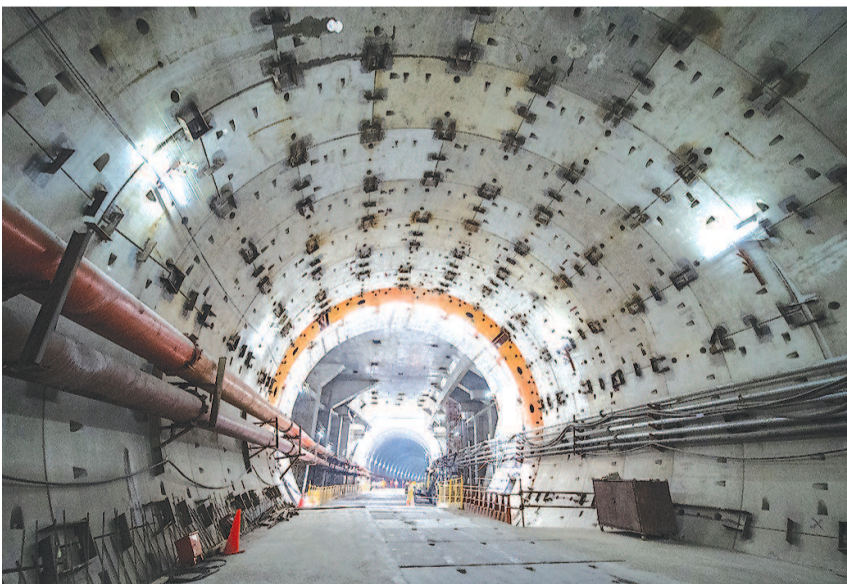
北横通道工程西线东段盾构顺利推进至600环
