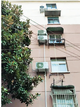
■为6楼居民安装空调排水管道
