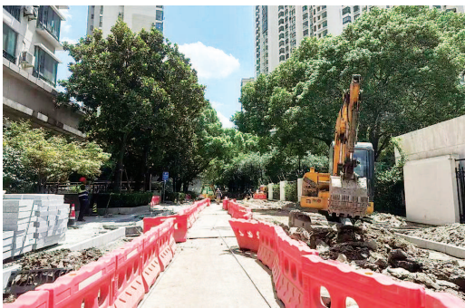
■优先推进的三号门区域道路修复现场
