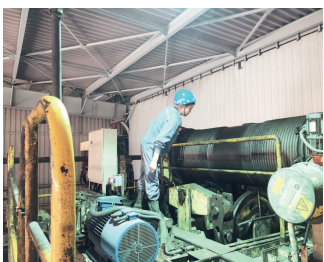
开展节前安全大扫除，当通过“拉网式”排查和“啄木鸟”查患等活动查改隐患和薄弱环节，对查出的问题分类统计，定期复查整改情况，实现安全无隐患、上岗无违章、操作无失误，筑牢安全屏障，确保“五一”安全
