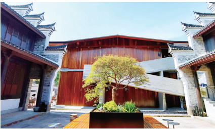
抱珠楼本体主楼新旧建筑
