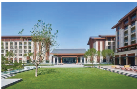
北京世园凯悦酒店外观建筑
