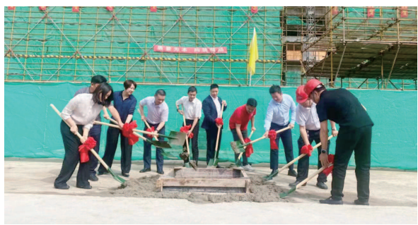
■小昆山镇乐芙娜奶酪工厂封顶仪式现场
