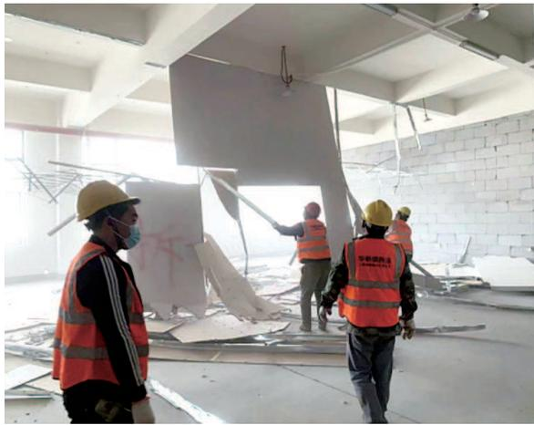
近日，青浦区华新镇综合整治办前往位于华新镇嘉松中路1708号的上海易代储仓储服务有限公司开展厂库房专项联合整治行动，针对企业内擅自改变房屋性质、违章隔断、占用消防通道等消防安全隐患问题进行拆除、清理，拆除面积为3500平方米。
