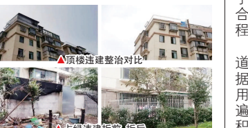
▲顶楼违建整治对比 ▲占绿违建拆除前后
