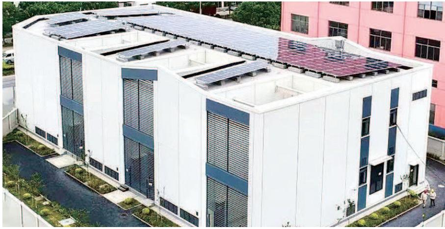
在奉贤区奉城镇，国网上海奉贤供电公司110千伏于庄变电站屋顶上满铺的光伏板在阳光的照射下熠熠生辉。9月28日于庄变电站建成投运后，这片总装机容量达96.3kWp的光伏板源源不断地吸收和转化太阳能，为变电站内除电力主设备外的所有装置设施提供运行所需电力，以“近零碳”的方式实现变电站内用电“自给自足”。
