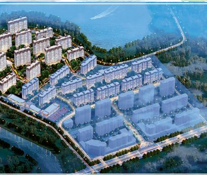
宁夏三鑫亚龙湾住宅小区项目位于贺兰县城城北,东侧,西侧及北侧紧邻如意湖,南侧为亚龙湾小区一期。该项目总用地面积为176899.74平方米,总建筑面积为358978.65平方米。项目建设内容为多层住宅(6层)、高层住宅(11-18层)、商业配套及一个9班幼儿园,另外包含15018.37平方米地下工程,平时作为汽车库、设备用房,战时作为二等人员掩蔽部人防工程。
