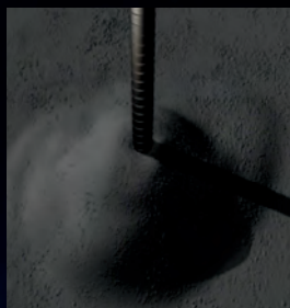
钻探取样器进行取样
