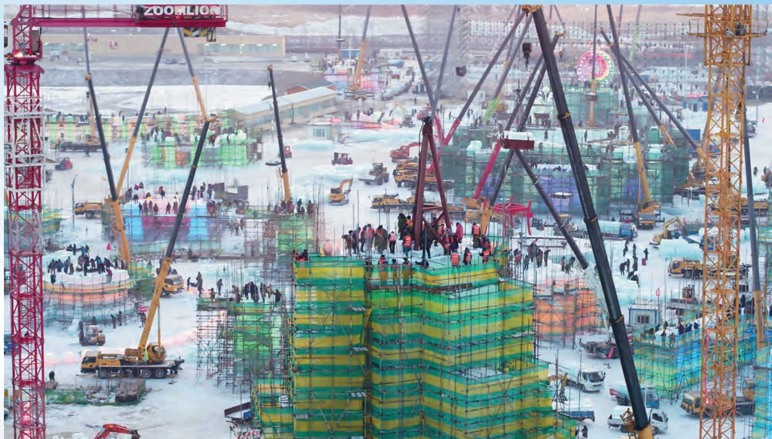
太阳岛冰建工地一番热火朝天的景象。
