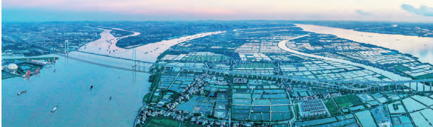
大湾区珠江口跨海跨江通道群掠影，南沙大桥全景。
