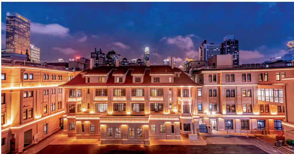
上图：位于上海市中心长乐路上的上海市第一妇婴保健院西院区。
