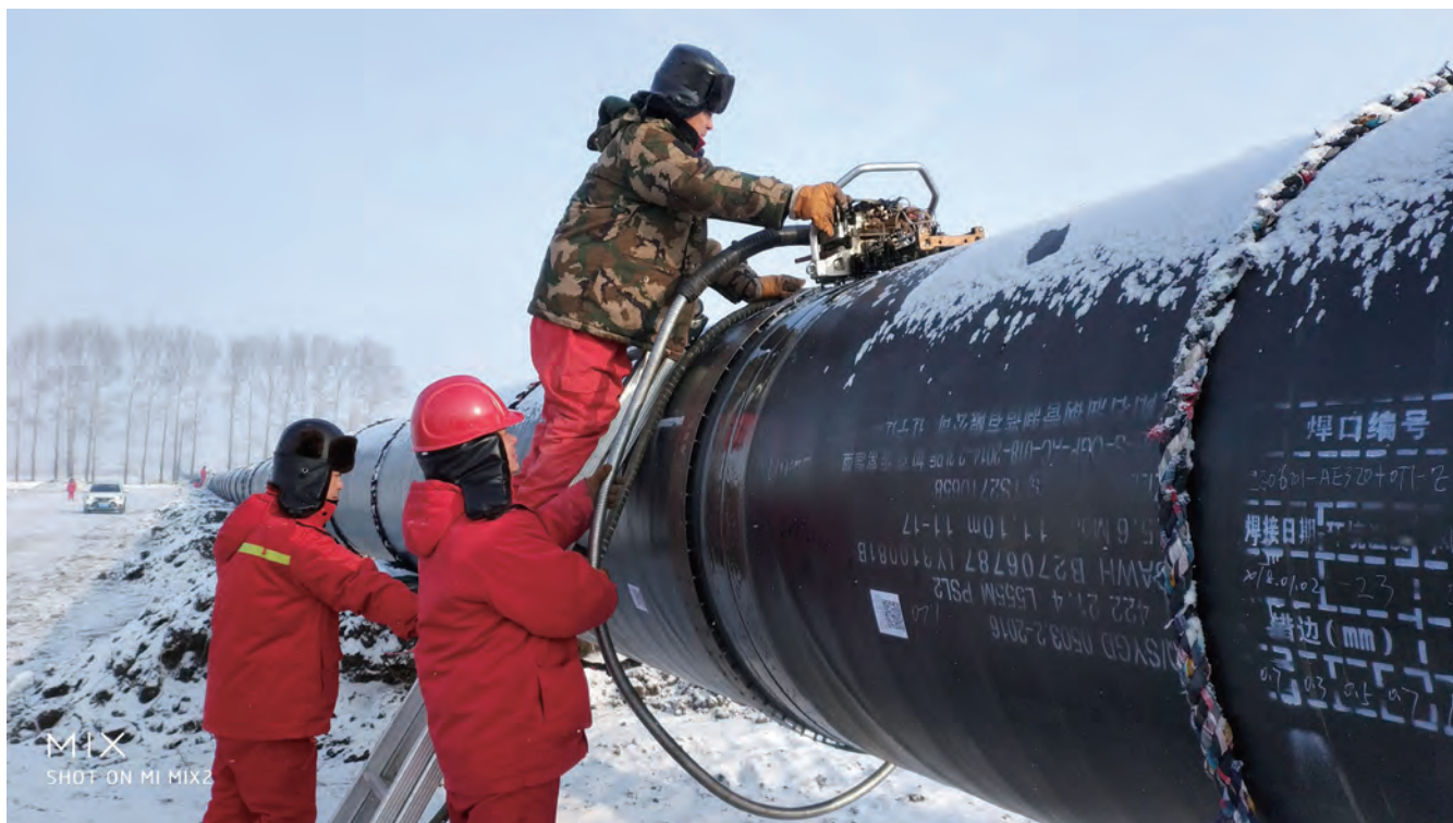
中俄东线检测施工严寒中进展顺利。
