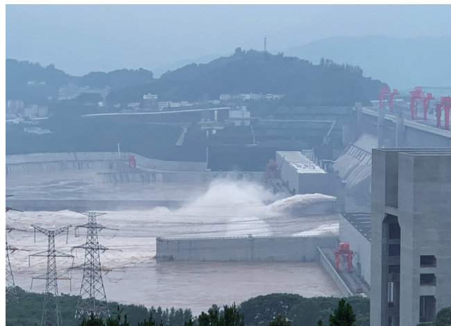
俯瞰三峡大坝泄洪壮观场面。摄影/王仲鸣
