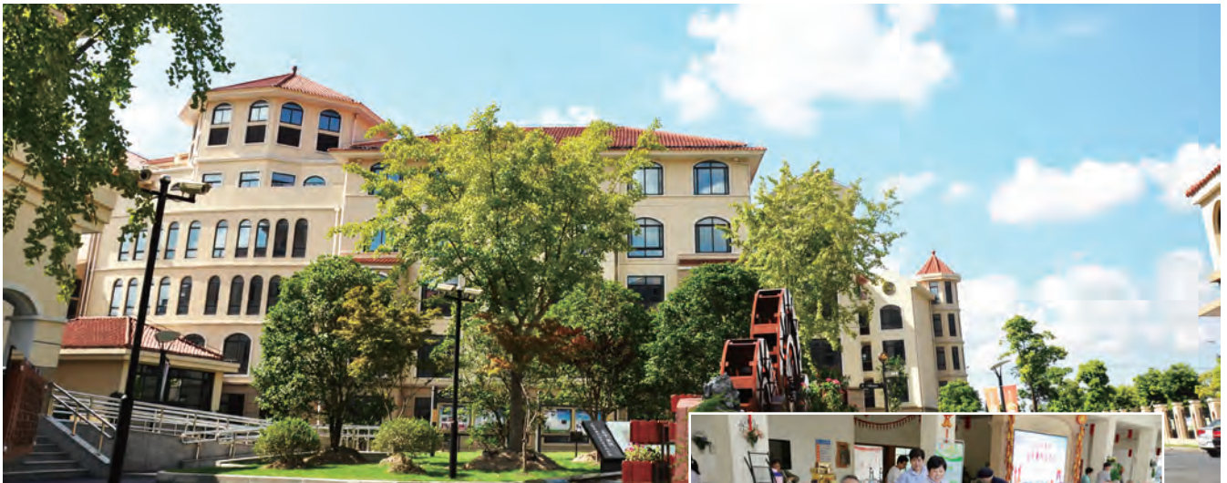
浦东新区浦惠明川养护院，是市内为数不多主要收治失智、失能老人的养老院。
