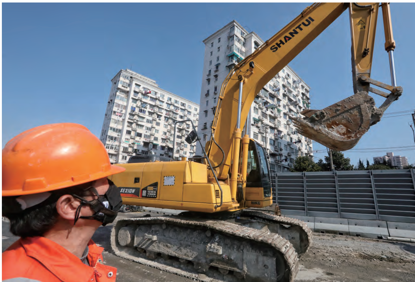
2020年2月21日，普陀区上海隧道项目工人正式复工。摄影/张龙
