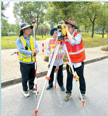
奉贤新城地下管线及道路要素更新维护项目外业测绘工作
