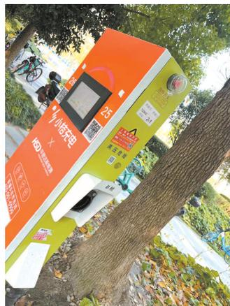
老客户。正常的使用流程是,扫码后,处于支起状态的地锁自动降落,车主拔出充电枪,给车辆供电。待充电完成后,放回充电枪,扫描“降地锁”二维码,地锁装置会发出报警声,提醒车主将车挪走后,才会自动下降。待车主将车辆从现场驶离后,地锁才会重新自动升起。
