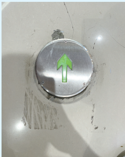
超市地面指示灯盖板没有完全固定，导致老人绊倒摔伤
