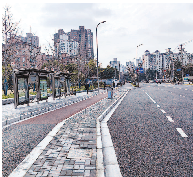
改造后的广粤路广中路公交站呈现“向内凹”的样式,不再影响原本道路的车辆通行 特约通讯员 龙钢 摄
