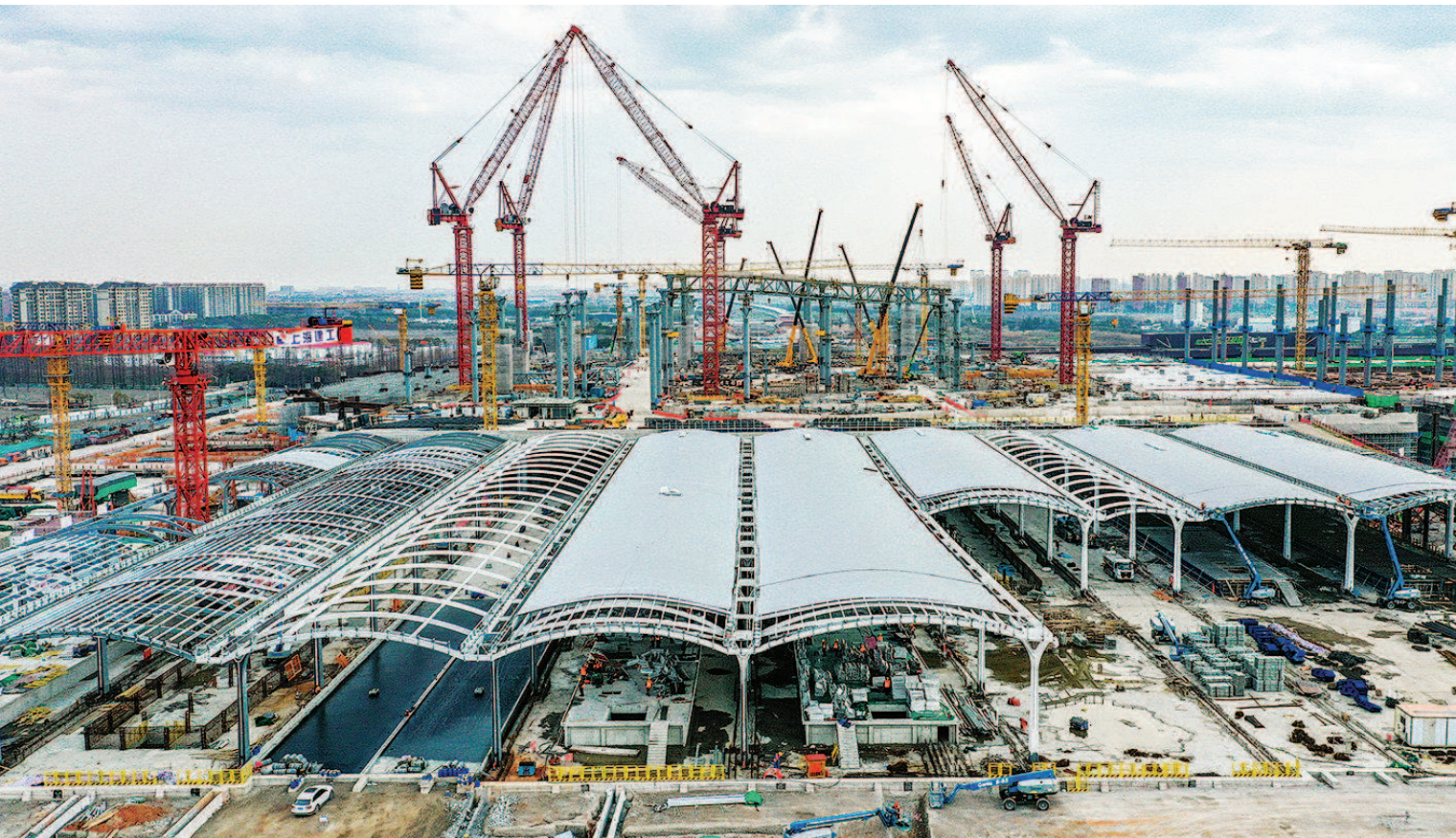
■昨天,沪苏湖铁路上海松江站项目施工现场十分热闹 本报记者 陶磊 通讯员 姜辉辉 摄
