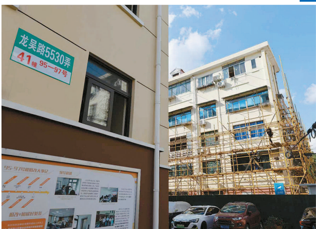
改造中的吴泾小区
