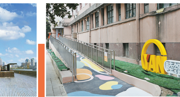
延吉七村居民区为高层住宅建设无障碍通道破解“八格台阶”问题
