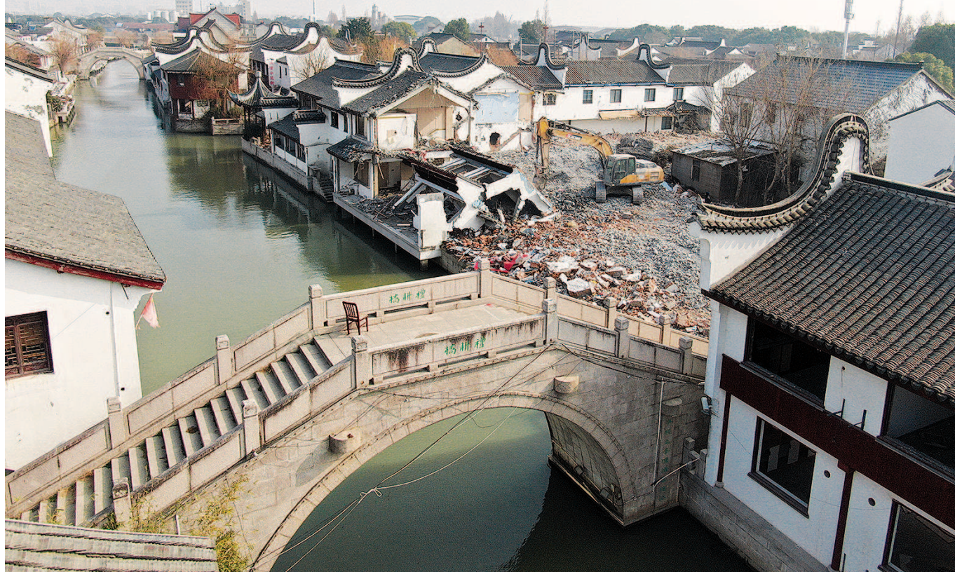
■ 召稼楼将打造为“国风水乡”。图为今天上午拍摄的项目推进现场
