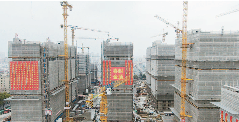
彭一小区成套改造项目封顶 本报记者 李铭坤 摄
