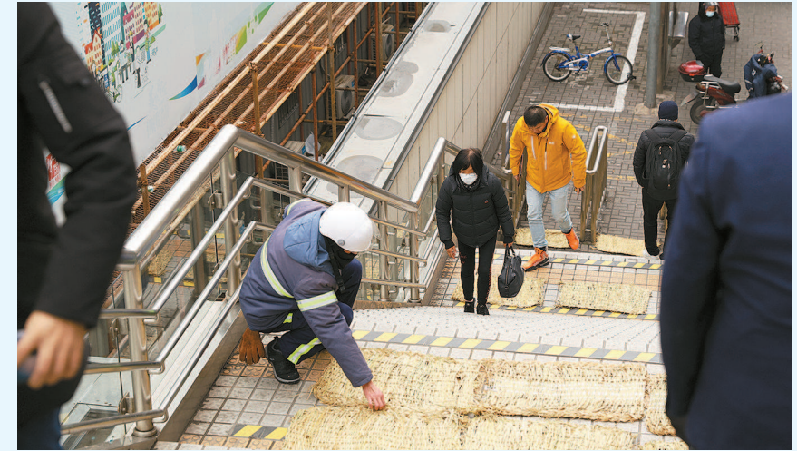
彭浦新村地铁站外，工作人员正在铺设防滑草垫
