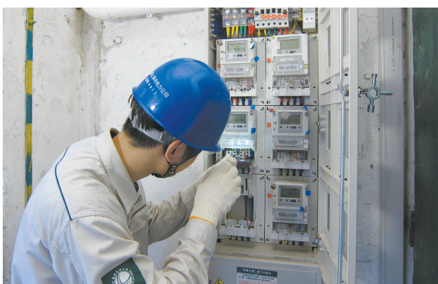
国网上海营销中心工作人员对电表进行状态更换
