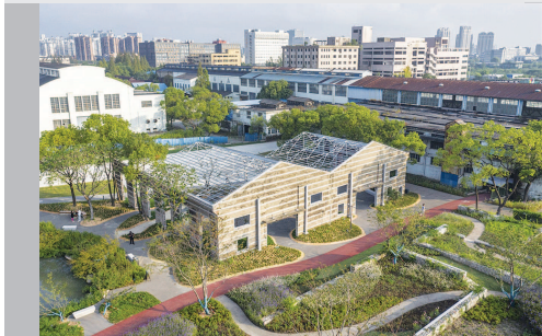
▲ 杨浦滨江电站辅机厂东厂遗留厂房打开屋顶引入阳光
