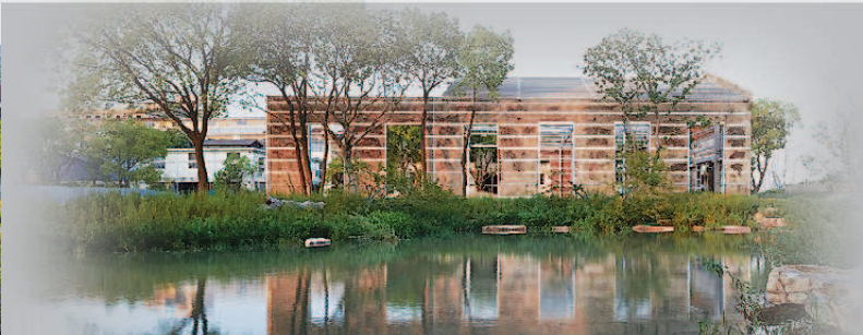
▲ 杨浦滨江电站辅机厂东厂改造后的生态水池
