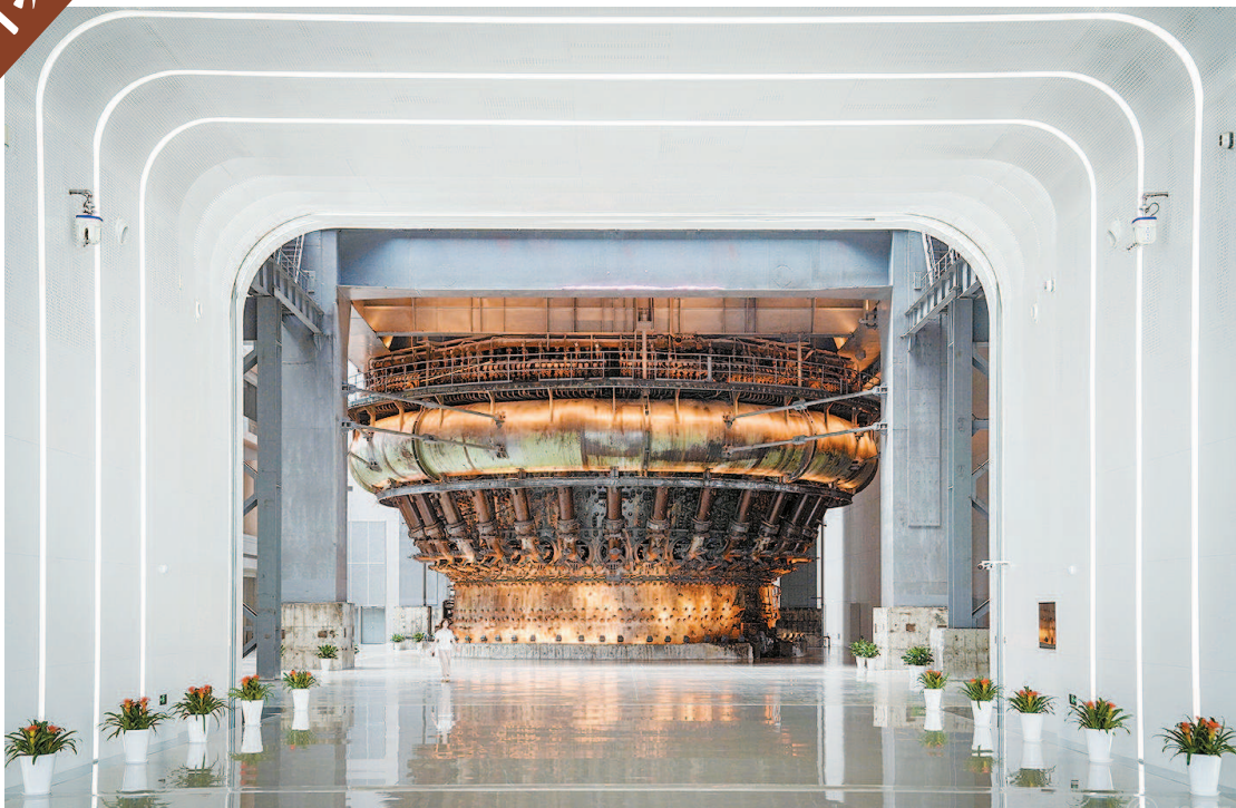
&gt;&gt;&gt; 金色炉台·中国宝武钢铁会博中心,整体占地约6万平方米,建筑面积4.47万平方米
