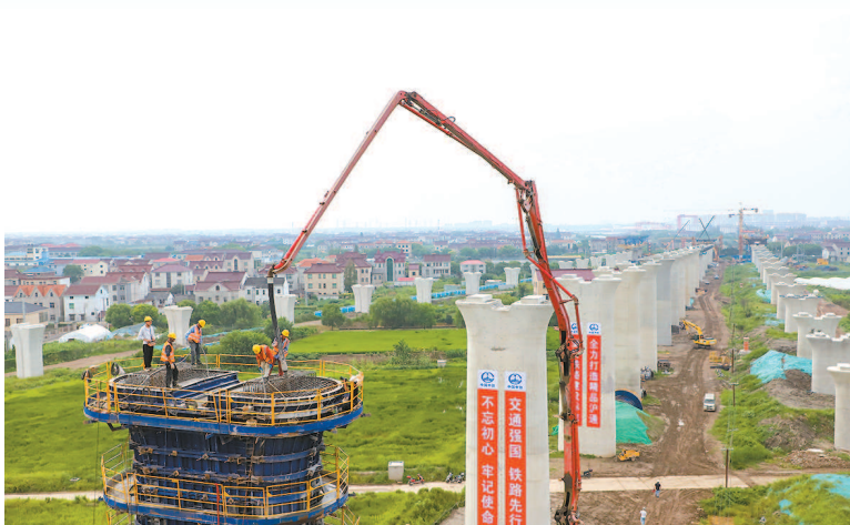
昨天,在特大桥施工现场,最后一方混凝土灌入墩身内
