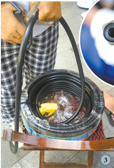
图① 工作人员安装燃具连接软管
