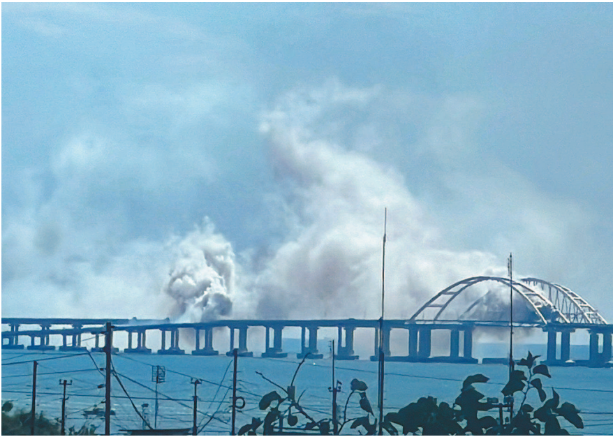
■ 克里米亚大桥冒出浓烟 图 GJ
