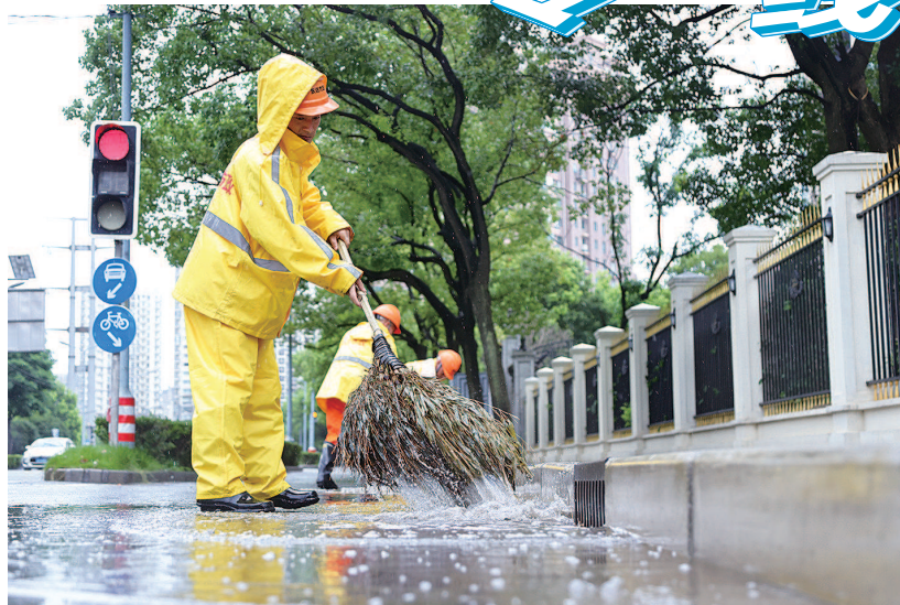
■ 台风天,清扫路面积水,清理雨水进水口
