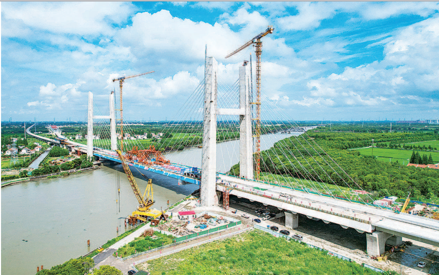
■ 国内首座高铁和普铁四线并行斜拉桥施工现场
